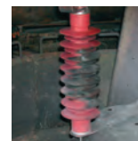
Sicheres Verhalten bei Kurzschluss
