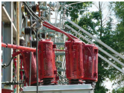
BCAC-IC mit geschlossenem Käfig (Gehäuse)
