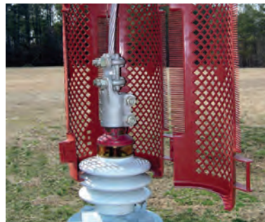
BCAC-IC mit geöffnetem Käfig(Gehäuse) während der Montage
