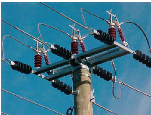
Leitungstützisolator in Verbundbauweise
